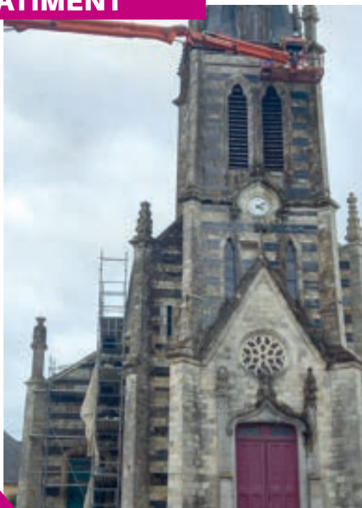
Nettoyage du clocher et peinture des abat-sons et portes du clocher
