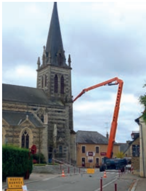
Nettoyage du clocher et peinture des abat-sons et portes du clocher
