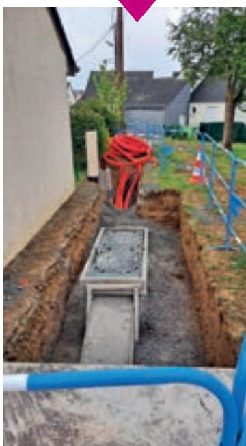
L'effacement des réseaux rue de la Voisinière
