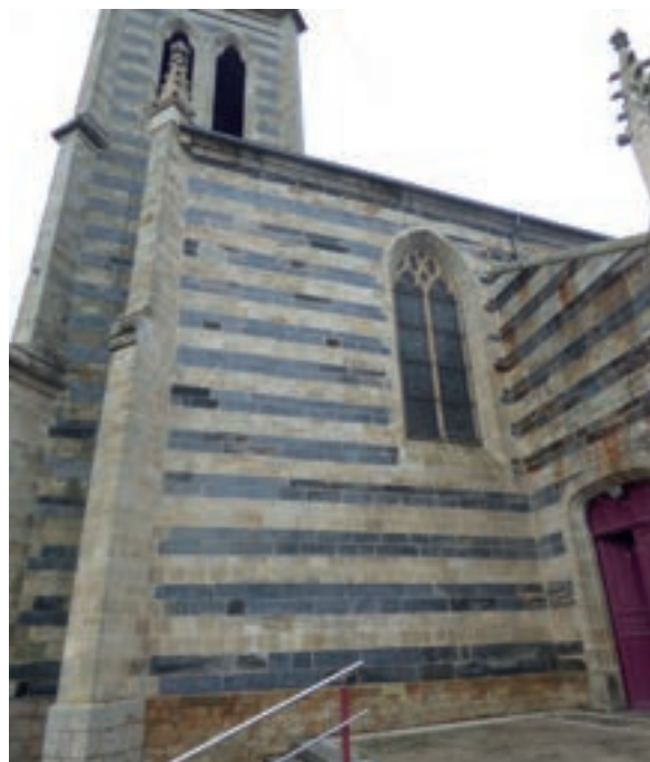
Rénovation des pierres de schiste
