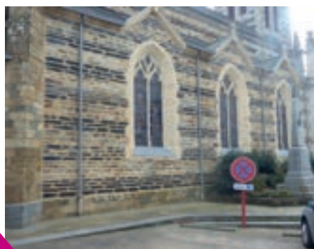
Nettoyage et rejointoiement
