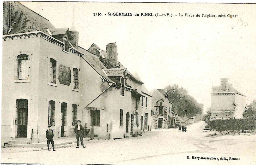
Saint-Germain-du-Pinel (I.-et-V.). - Place de l'Eglise et route d'Argentré.
